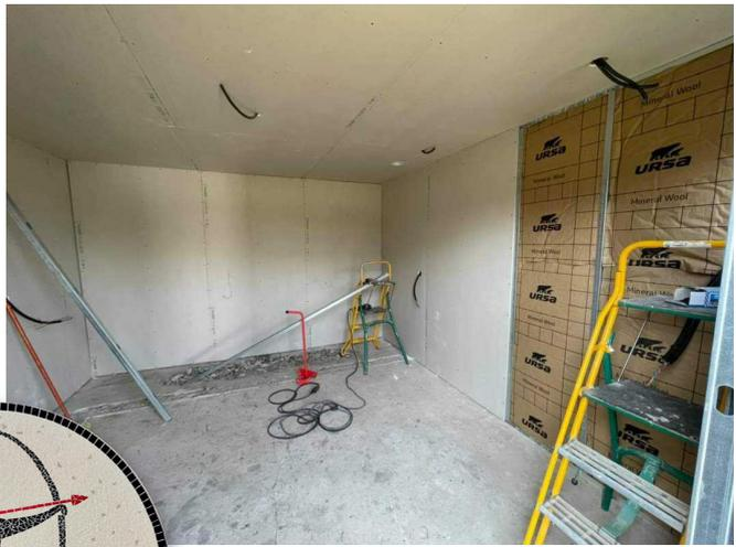
La partie centrale en cours de travaux, avec isolation, placoplâtre et éclairage.
